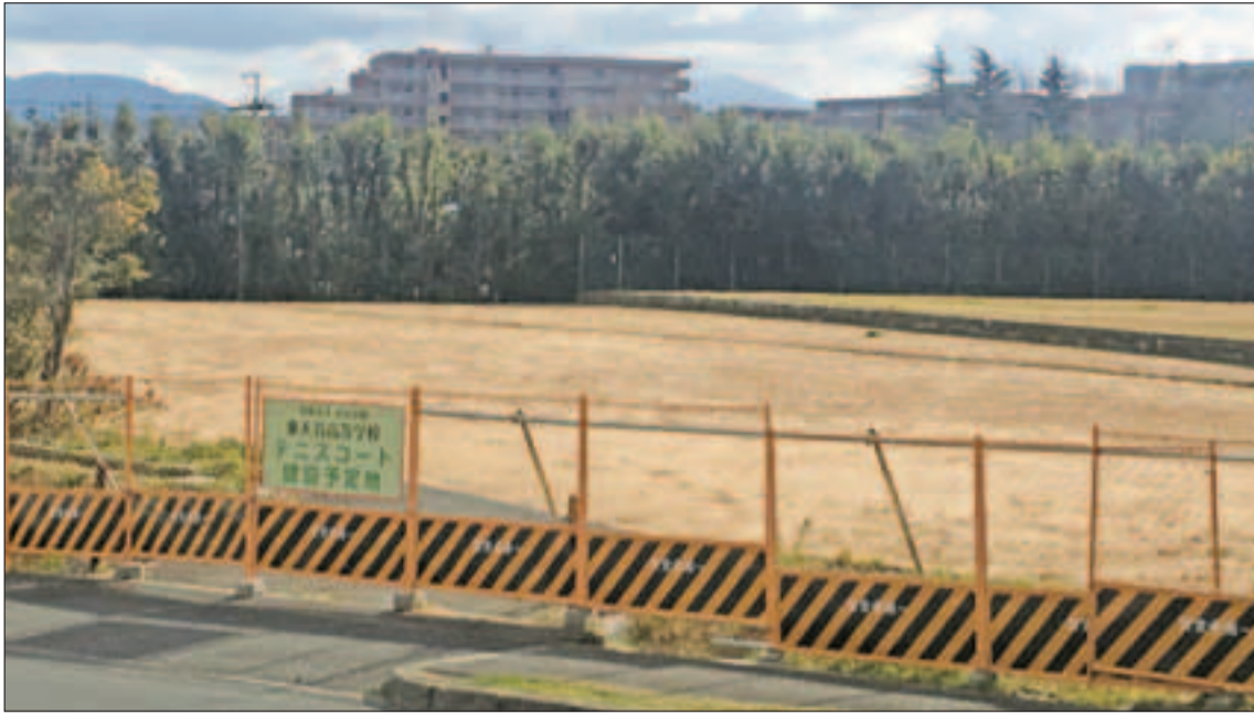
4月からテニスコート2面の工事が始まる
